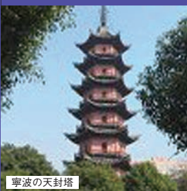
寧波の天封塔
