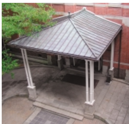
改修された尋源館車寄
