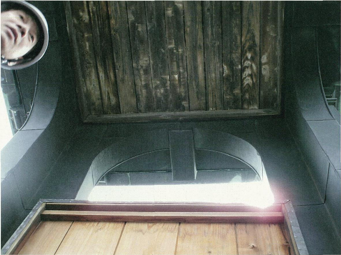
↑塔の天井。全面板張りであった。
